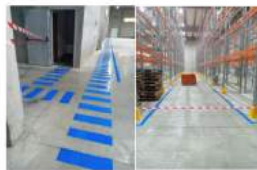
Traçage entrepôts logistiques
